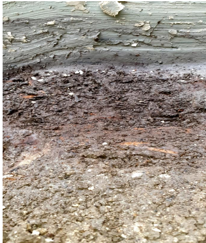
Übergang der Lehm-Kohleschicht
