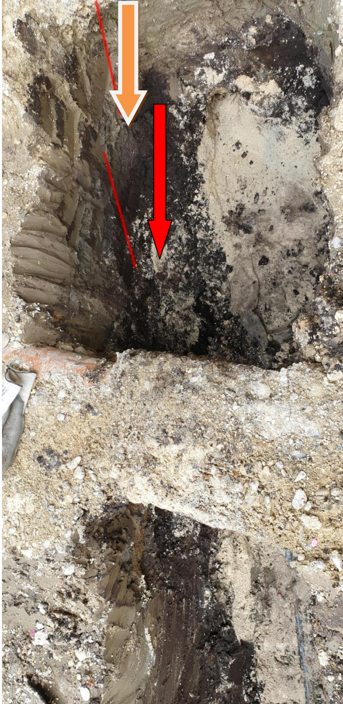
Trinkwasserzuleitungsgraben am Anfang des Hausfundamentes
